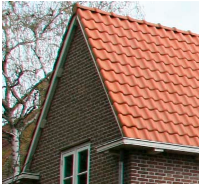
Daken belegd met keramische pannen (verbeterde holle pan) en houten bakgoten op klossen omgezet bij de kop
