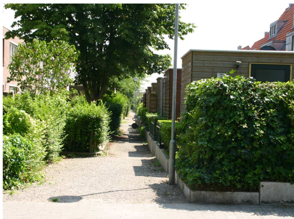
peilverschillen na nieuwbouw aan een achterpad; Meiendaal-Langegeer
