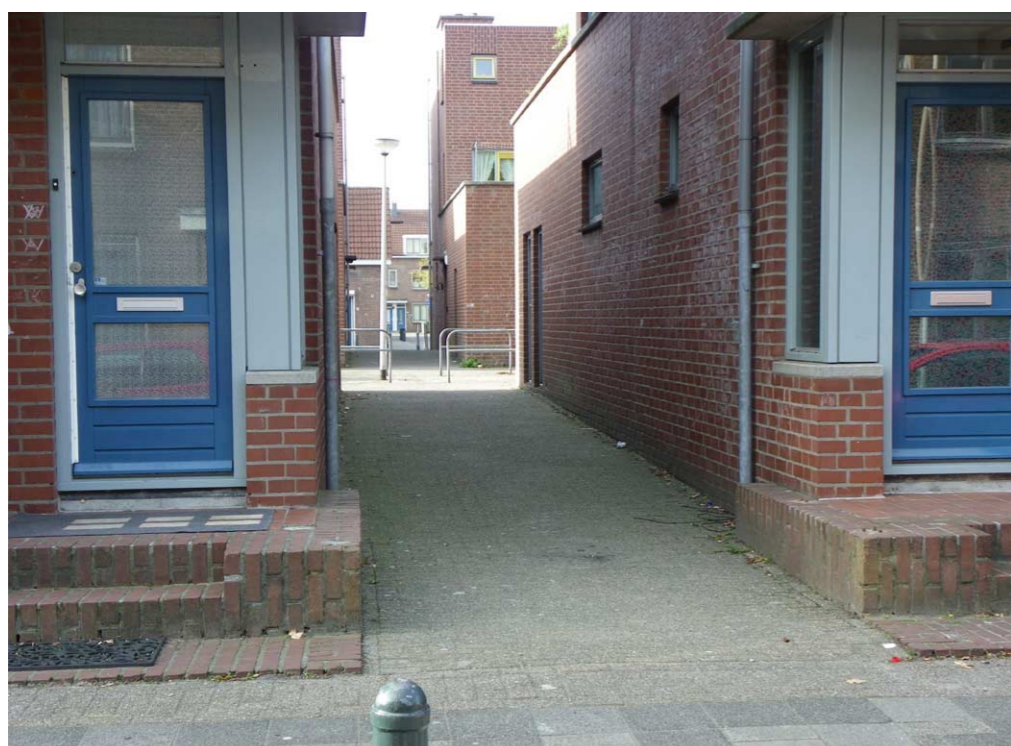
peilverschillen na nieuwbouw; Zeisstraat
