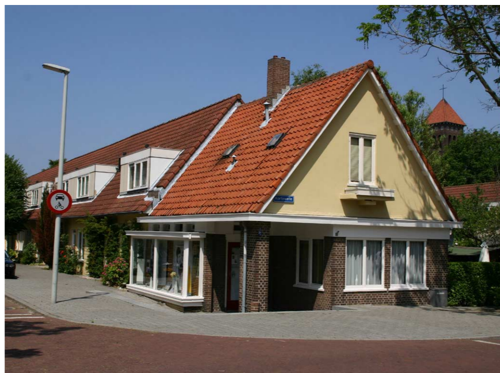
peilverschillen na nieuwbouw; kapperzaak op de hoek Meiendaal-Kortewelle
